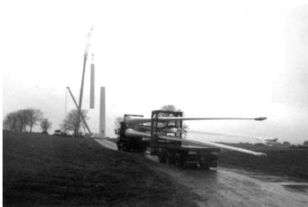
Gráfico 7.6: Cargamento de aspas y torre en construcción (Healion, 2005)
