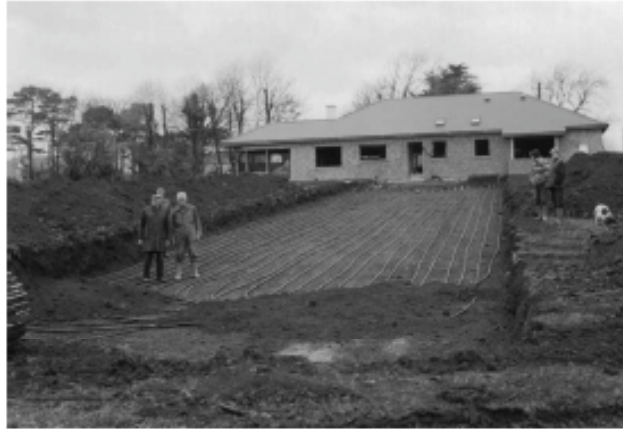
Gráfico 4.6 Instalación de un calefactor horizontal en una vivienda (Dunstar, 2006)
