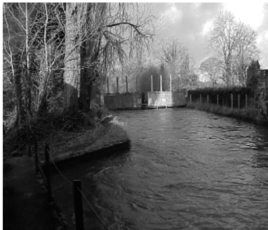
Gráfico 8.8. Cabecera de un proyecto hidroeléctrico (Hoyne, 2006)
