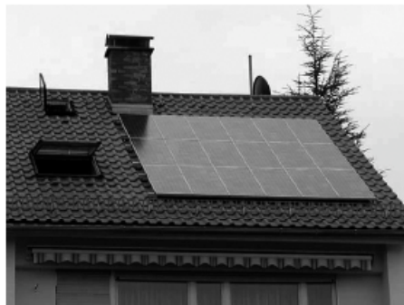
Gráfico 5.1 Conjunto de placas montadas en techo (Krannich Solartechnik; Evergreen solar 2005)
