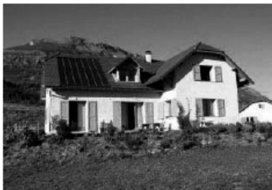
Gráfico 6.14 Ejemplo de un sistema combinado termosolar de 16 \text{ m}^2 en una casa situada en Francia
